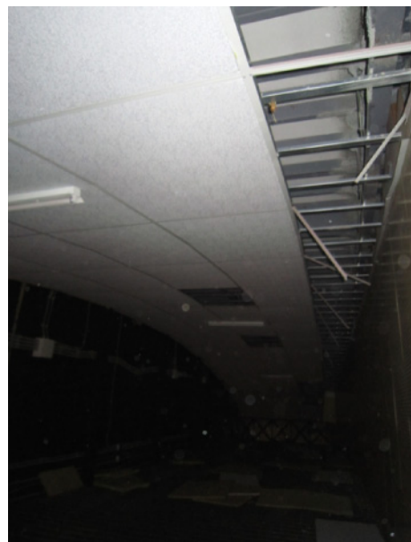
体育館ステージ天井
