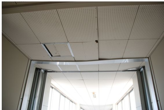
2F 連絡通路 接合部
