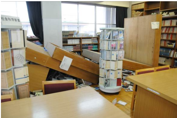
写真1 転倒した書棚（図書室）
