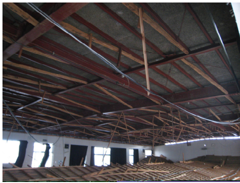
特別教室棟 2階廊下天井給水管破断による漏水，音楽室・視聴覚室天井落下 卓球場 天井全面落下，外壁面の崩落
