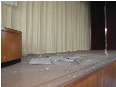
体育館 ステージ天井のコンパネ落下，内壁破損，照明破損，外壁落下
